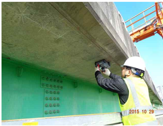
위 치 바닥판하면 내 용 철근탐사
