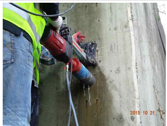
위 치 교대 내 용 코어 채취
