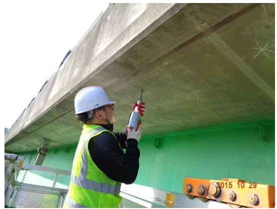
위 치 바닥판하면 내 용 반발경도 시험 측정
