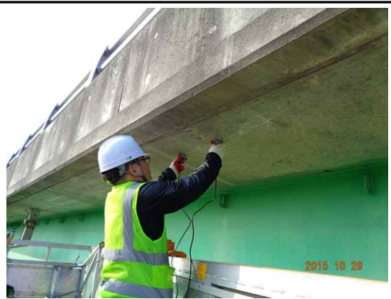
위 치 바닥판하면 내 용 초음파 강도시험
